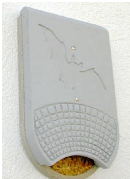
Exemple de gîte à chauve-souris à fixer contre le bâti
